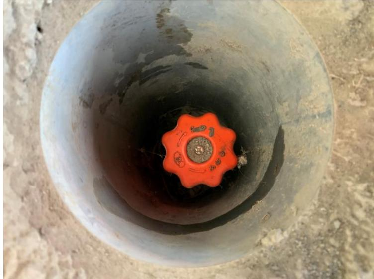
水抜き栓・止水栓
