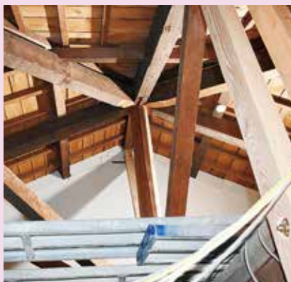
堅牢な屋根裏の一部
