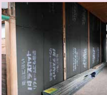
2F西側 耐震補強材耐力壁の設置風景
