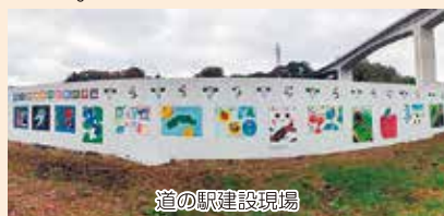
道の駅建設現場
