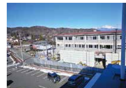
佐久南庁舎解体
