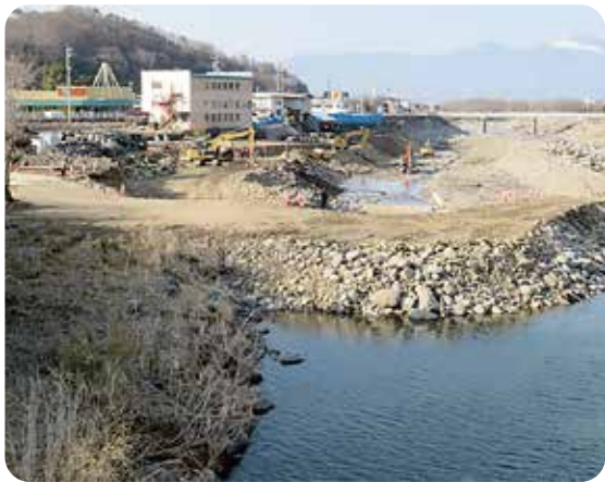
復旧工事が進み始めた米橋下の千曲川左岸工事
