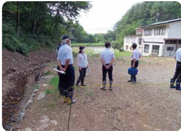
復旧した曽原ため池と水路
