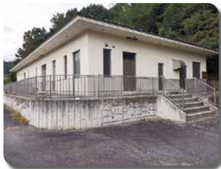
上地区農業集落排水施設
