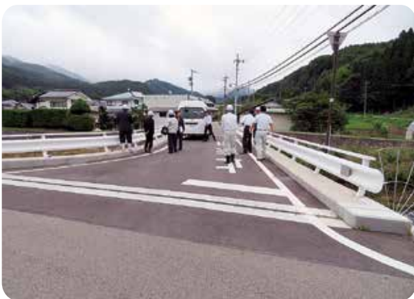
大日向・池の尾橋の工事完了の確認
