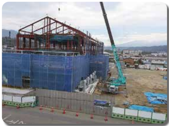
新庁舎工事の現状
