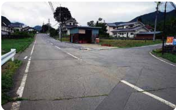
白矢線舗装改良工事
