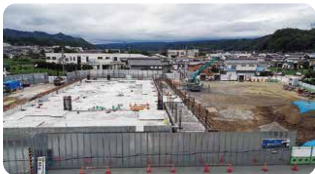
新庁舎建設7月5日の状況
