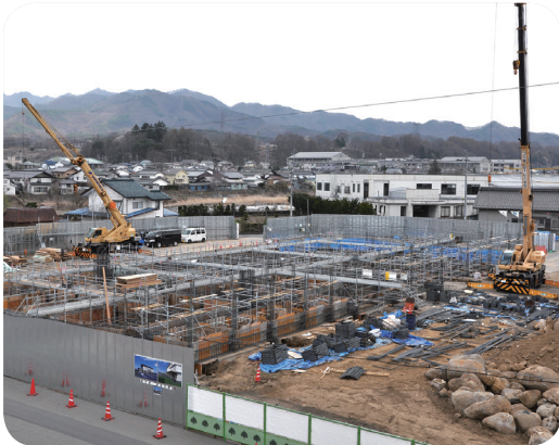
新庁舎建設状況
