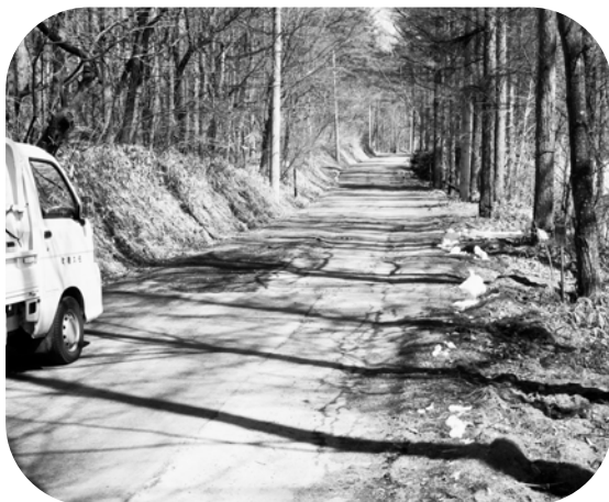
八千穂高原別荘の水道管布設替場所
