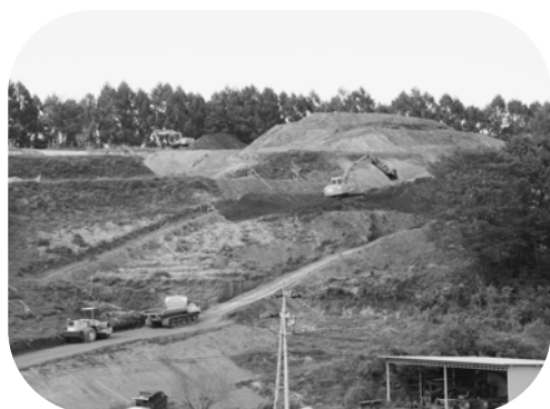
大量の残土が出る中部横断自動車道
