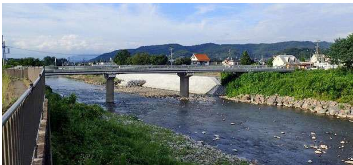
町道宿岩黒下駅線 八十巖橋
