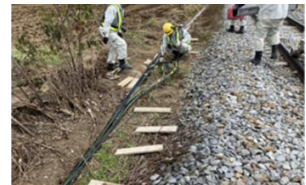
鉄道ケーブル修繕
