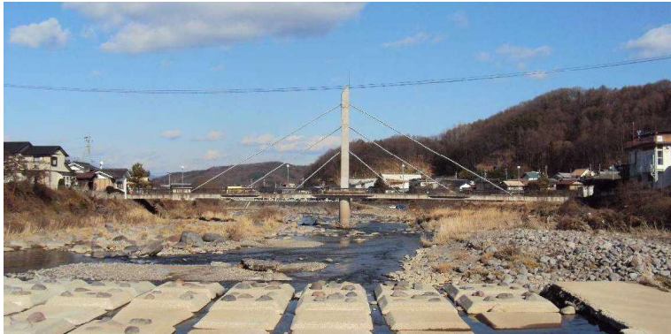
写真 3.3.1 町道四ツ谷高野町線 栄海橋
