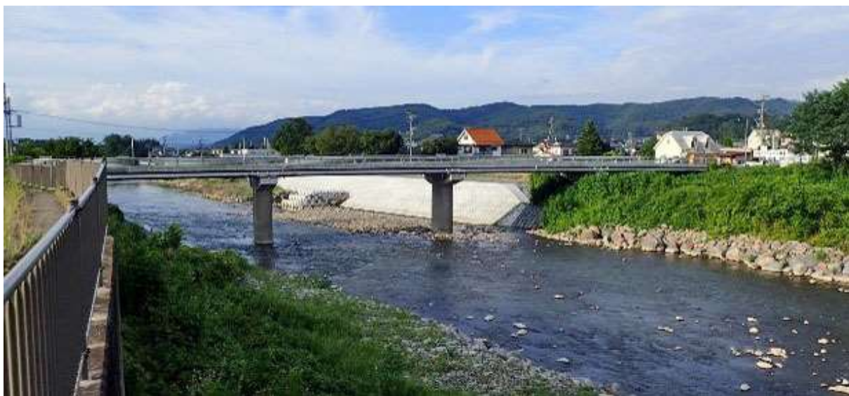
町道宿岩黒下駅線 八十巖橋
