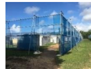
防風ネットの設置
