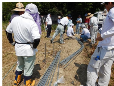
災害復旧の取組実証
