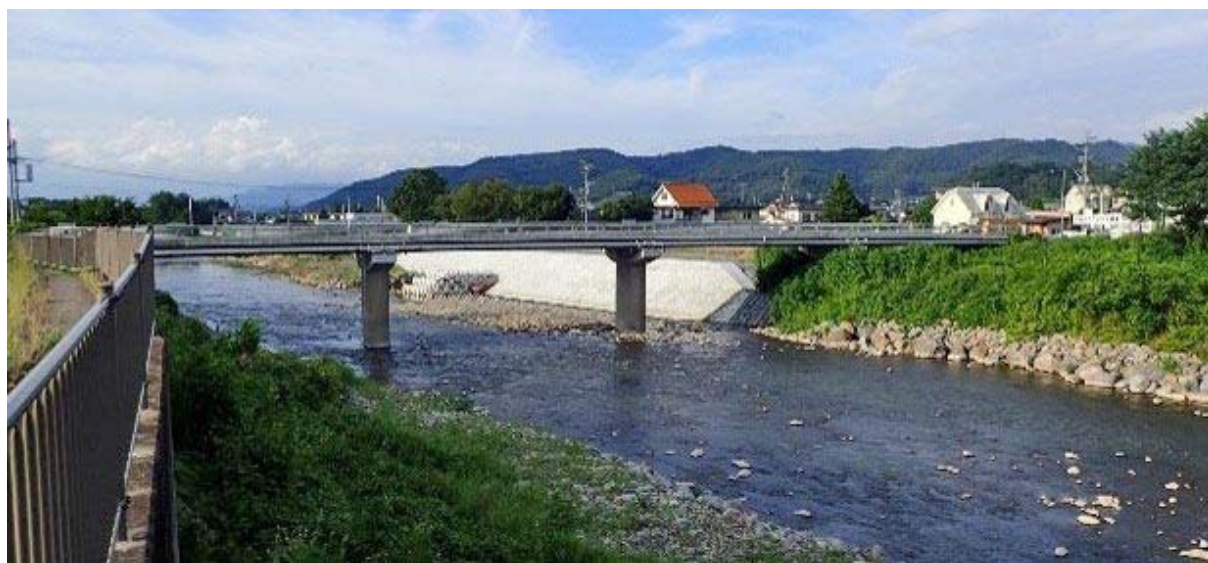
町道宿岩黒下駅線 八十巖橋
