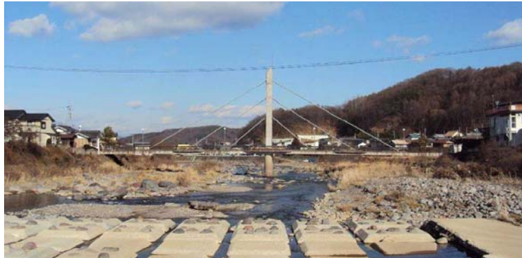
写真 3.3.1 町道四ツ谷高野町線 栄海橋
