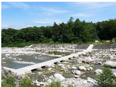
駒ヶ根太田切川の帯工 (渡河機能付施設)
