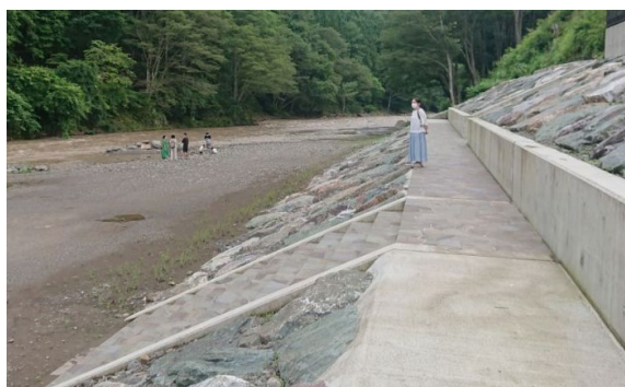
道の駅 うへの 護岸・階段整備
