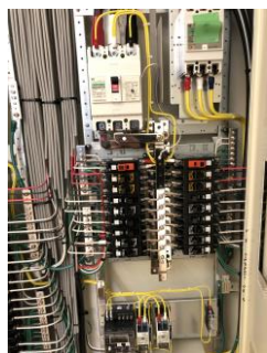
＜某施設照明設備＞
