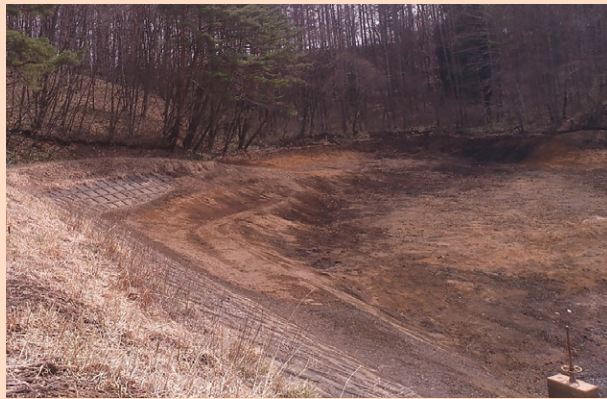
浚渫（しゅんせつ）工事中の小山温水ため池
