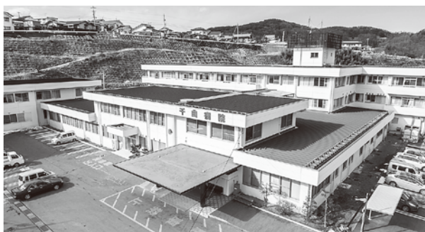
町立千曲病院外観
