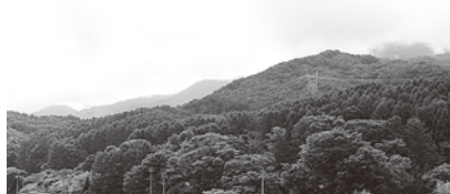
大日向発電所遠景
