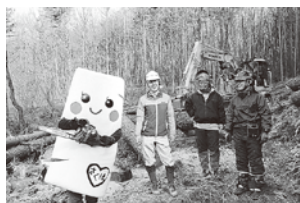
(株) 吉本伐採現場
