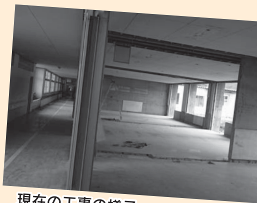
現在の工事の様子
