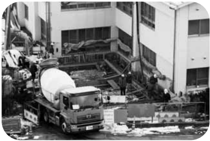
老健の工事が進む
