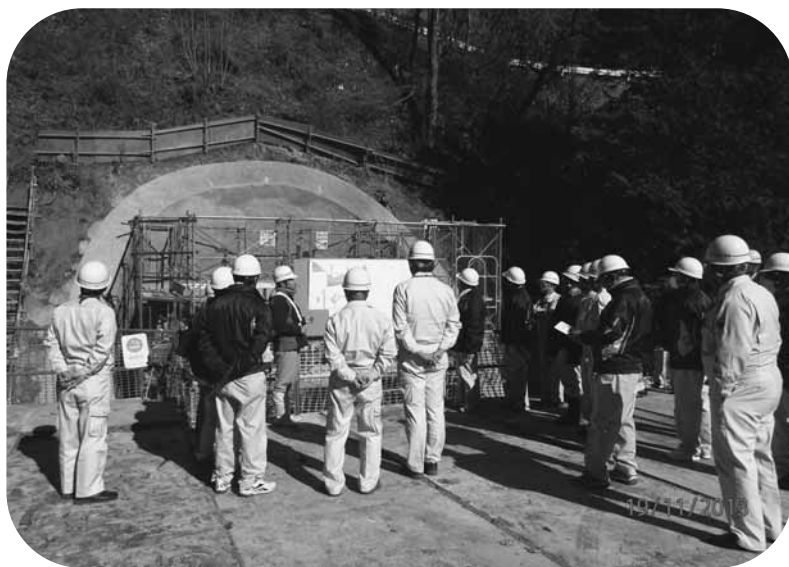
南牧村議会による高速道路建設地視察
