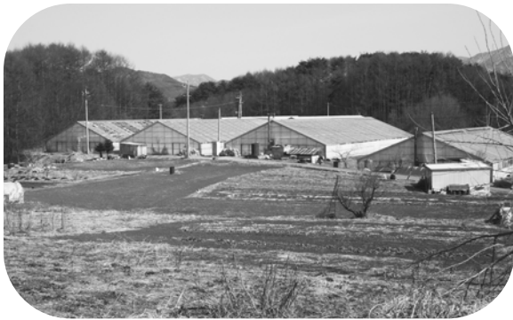
峰沢地籍の園芸施設
