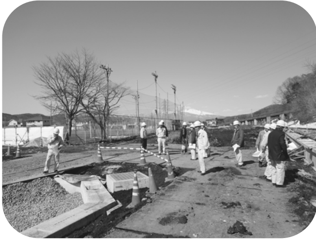
統合小中学校建設工事
