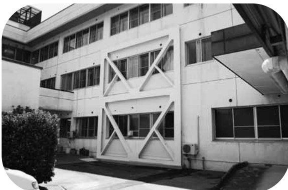
耐震補強された病棟
