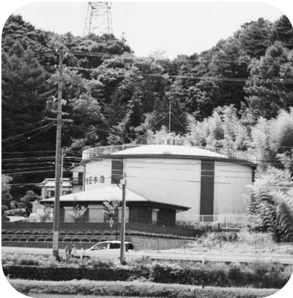
佐久水道配水池
