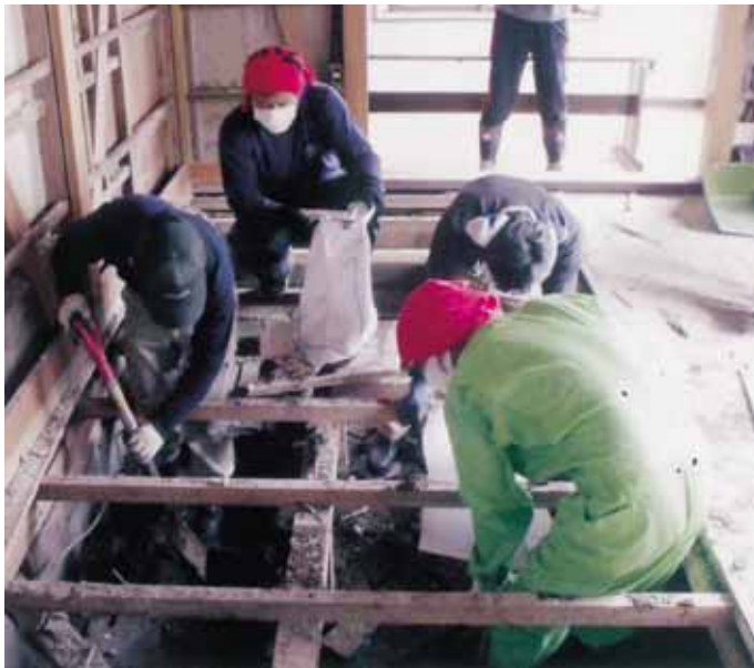
床下のヘドロの排出
