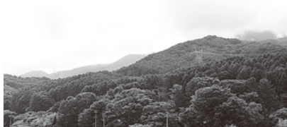
大日向発電所遠景
